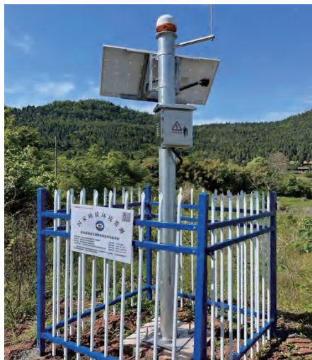
四川省西充市 2021 年地质灾害群 专结合监测预警项目安装完成图
