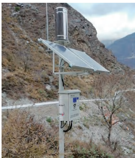
团风县贾庙乡胡家山二组崩塌
