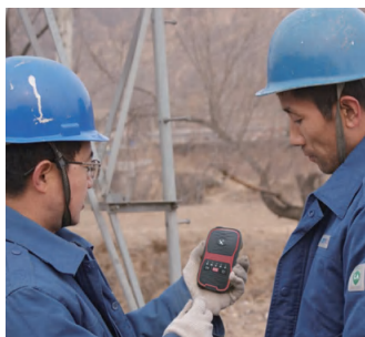
无人区工地施工，信息回传
