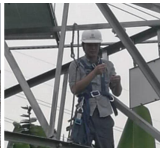
电力施工巡检
