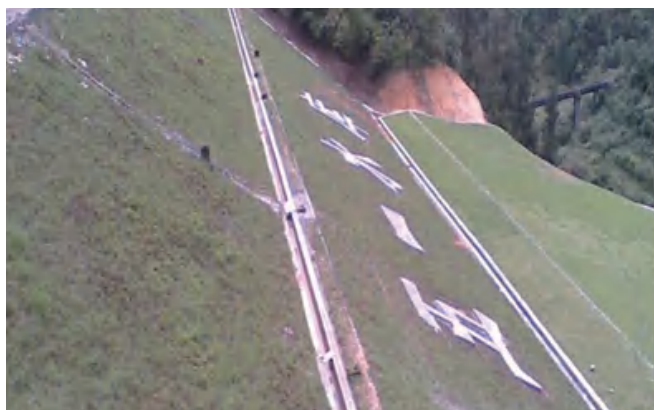
福建永春五一水库大坝 图 02
