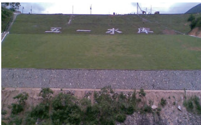
福建永春五一水库大坝 图 01
